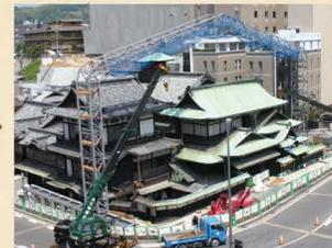
1つ目のフレームの組み立てが完了。本館保存修理1期工事は全部で9つのフレームで素屋根が構成されます。(令和元年6月5日)
