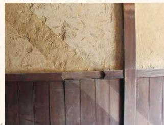
南棟の東脱衣室内で発見された階段の跡。昔の図面・資料などによる考察から、建築当初の大正13年(1924)から昭和15年(1940)まで使用されていた階段と推測されます。
