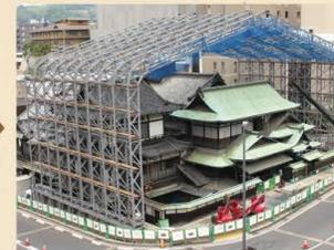
9つのフレームの組み立てが完了。又新殿・霊の湯棟、南棟の一部が覆われました。(令和元年6月10日)
