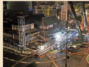
素屋根工事は大型クレーン2台を設置するため、夜間、道路を封鎖して行いました。(県道全面通行止)
