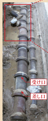
工事中の中央廊下、陶管
