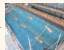
防水シート設置
