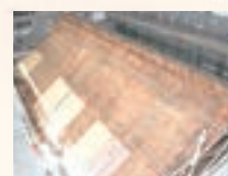
野地板部分修理
