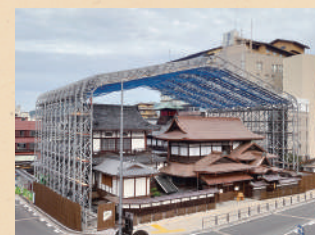
鉄骨フレーム東側解体
