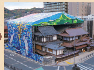
仮囲いを設置
