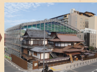
鉄骨フレーム西側へスライド
