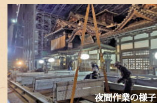
夜間作業の様子
