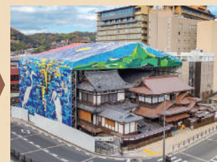
テント膜を設置
