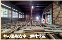
神の湯脱衣室 解体状況
