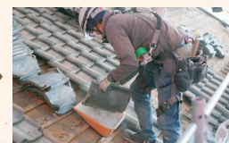
瓦の解体状況
