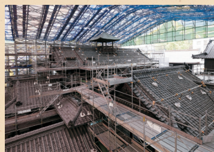
後期工事 外部足場
