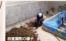
浴室掘削の様子
