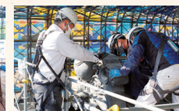
鬼瓦解体状況
