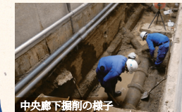
中央廊下掘削の様子
