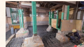
鉄筋コンクリート補強(基礎)
