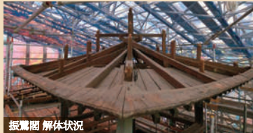
振鷲閣 解体状況
