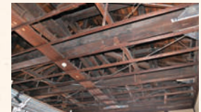
鉄筋ブレース補強(天井裏)
