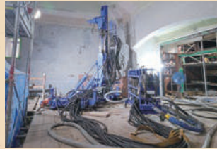
施工中の浴室状況
